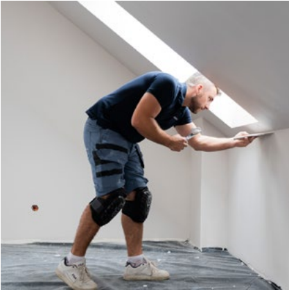
Gładzie na ścianach i sufitach
