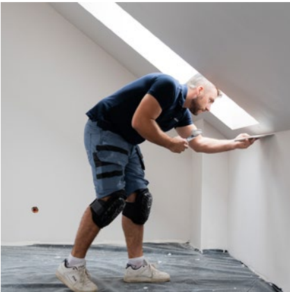
Gładzie na ścianach i sufitach
