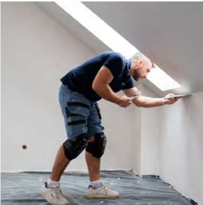
Gładzie na ścianach i sufitach
